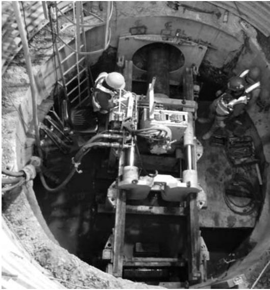
用於頂管施工的頂管機
